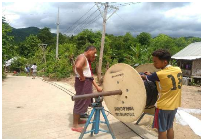
ပုံ - ရွှေတောင်ဘိလပ်မြေကုမ္ပဏီမှ ကူပြင်ကျေးရွာအတွင်း ဗို့အား(၄၀၀)ရှိသော မီးလိုင်း တည်ဆောက်ပေးခြင်း။
