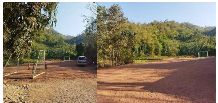
ပုံ - ကူပြင်ကျောင်းအားကစားကွင်း (ဘောလုံးကွင်း) တိုးချဲ့ပြုပြင်ဆောင်ရွက်ပေးထားခြင်း။
