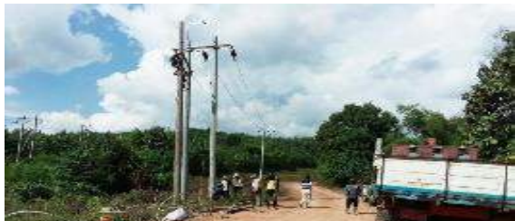
ပုံ - ရွှေတောင်ဘိလပ်မြေ စက်ရုံ ၃၃ ကေဗီ ဓာတ်အားလှိုင်း မှ ကူပြင် ကျေးရွာ သို့သွယ်တန်းသည့်မီးလှိုင်းတွင် Auto-Recloser နှင့် DS တပ်ဆင်ပေးခြင်း
