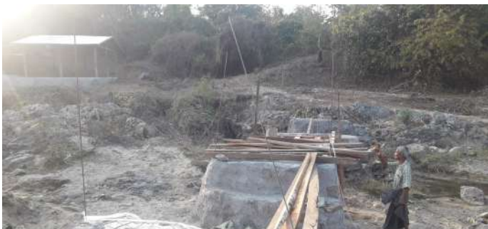
ပုံ - ပုပွားကုန်းကျေးရွာ တွင်ချောင်းကူးတံတားတည်ဆောက်ခြင်း။
