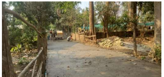
ပုံ - ပြည်ညောင်ကျေးရွာအတွင်းရှိ ရပ်ကွက်လမ်းများအား ကွန်ကရစ်ခင်းခြင်း။
