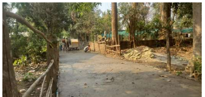
ပုံ - ပြည်ညောင်ကျေးရွာအတွင်းရှိ ရပ်ကွက်လမ်းများအား ကွန်ကရစ်ခင်းခြင်း။
